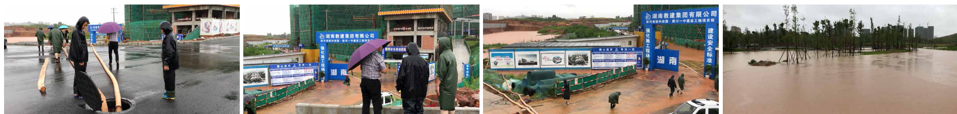
▲防汛抢险现场
